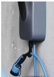
Slika 2: Zasebna polnilna točka s stensko polnilno postajo vir: ETREL
