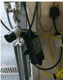
Slika 1: Domače polnjenje z nadzorno komponento (ICCB) Vir: B.A.U.M. Consult
